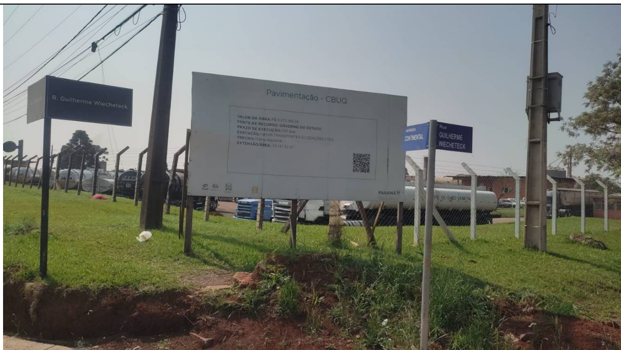
Placa de obra – SAM 199 – L.1. Placa de obra em estado médio de conservação, foi despregada.
