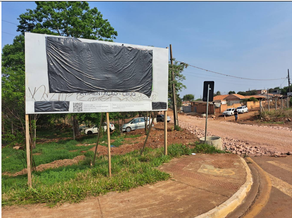
Placa de obra – SAM 210 – L.1. Placa de obra em mal estado de conservação, pichada e coberta por adesivo.
