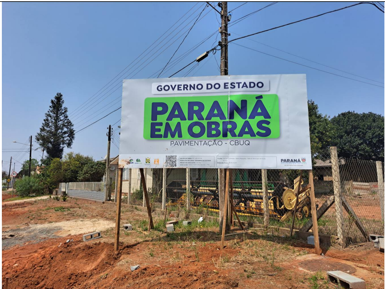
Placa de obra – SAM 213 – L.1. Placa de obra em estado médio de conservação, suja e precisando de reforço na estrutura.
