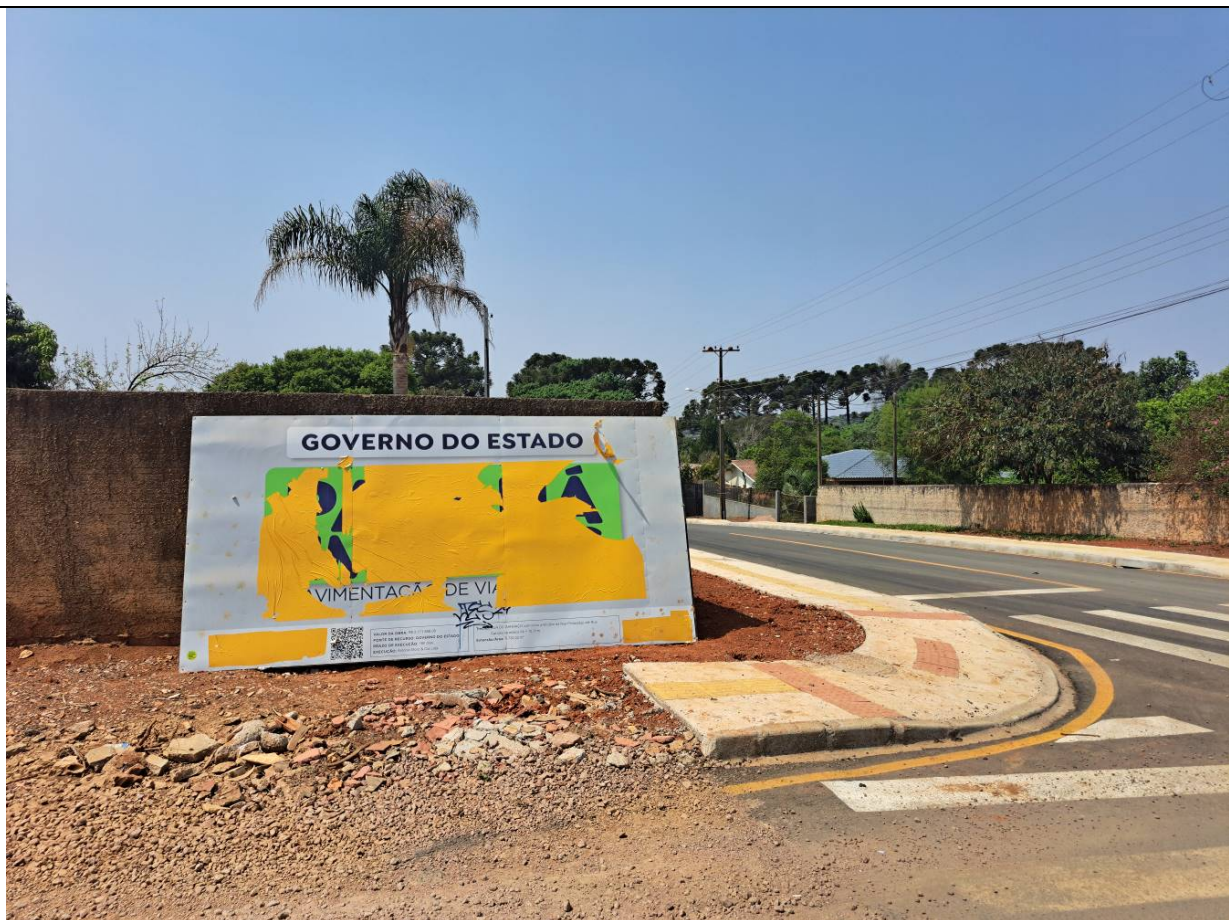
Placa de obra – SAM 206 – L.1. Placa de obra em estado médio de conservação, porém sem estrutura e coberta por adesivo.
